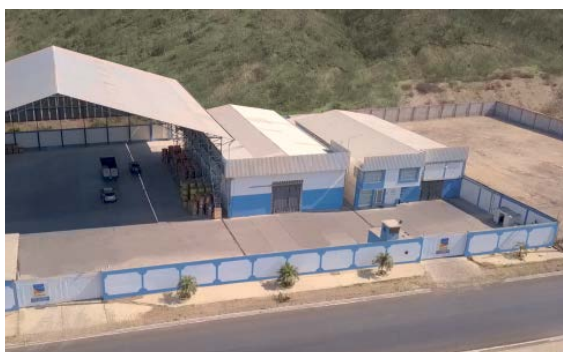
◀ Sucursal Manta Av. Principal s/n Vía San Juan de Manta.
